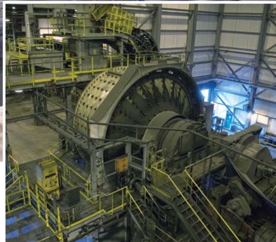
SAG Mill, Voisey's Bay, Labrador
